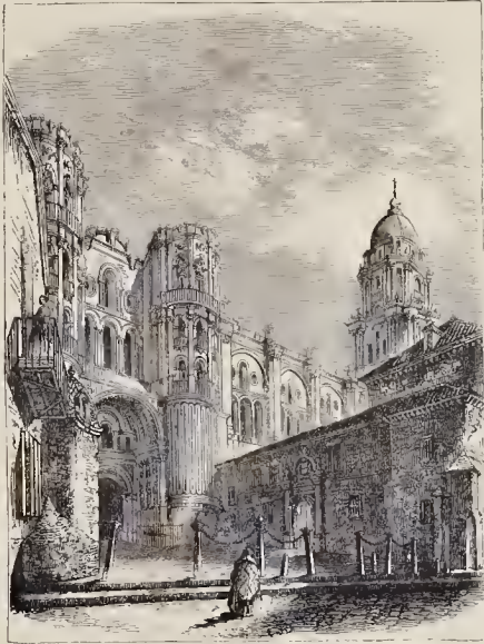
PUERTA DE LAS CADENAS, CATHEDRAL OF MALAGA.
